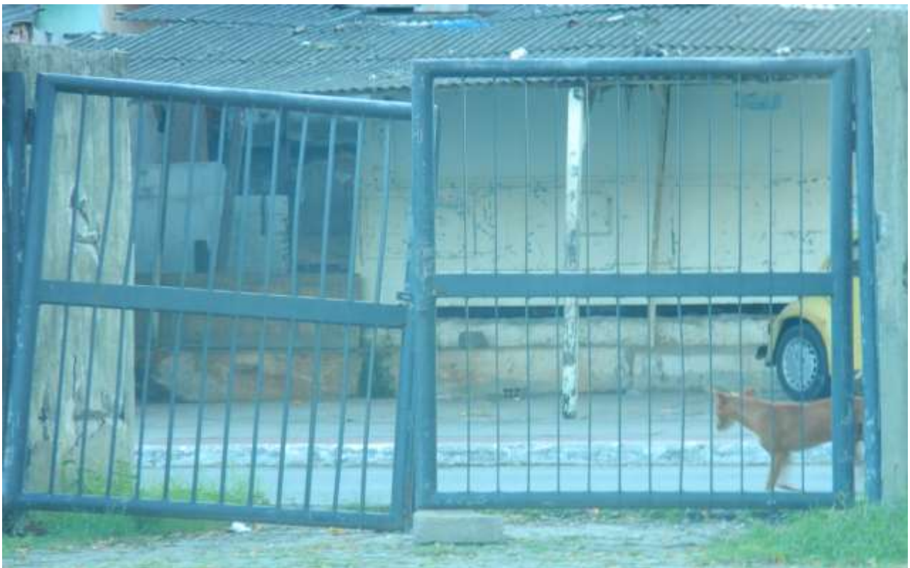
Foto 10 - Portões quebrados e abertos constantemente (área sem segurança).
