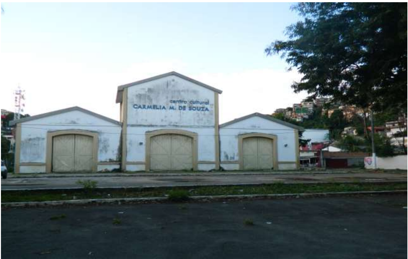
Foto 02 – Fachada da RTV de televisão (entregue à própria sorte).
