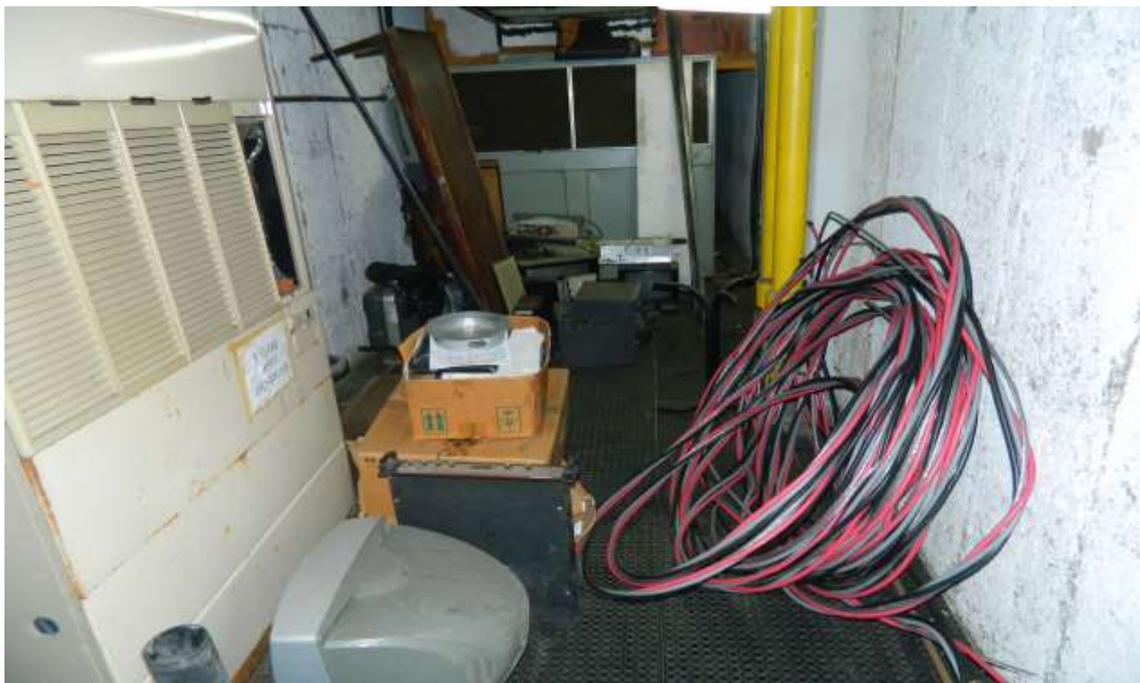
Foto 15 - Resto do cabo amarrado na copa e máquinas do ar condicionado quebradas, possíveis riscos de acidentes
