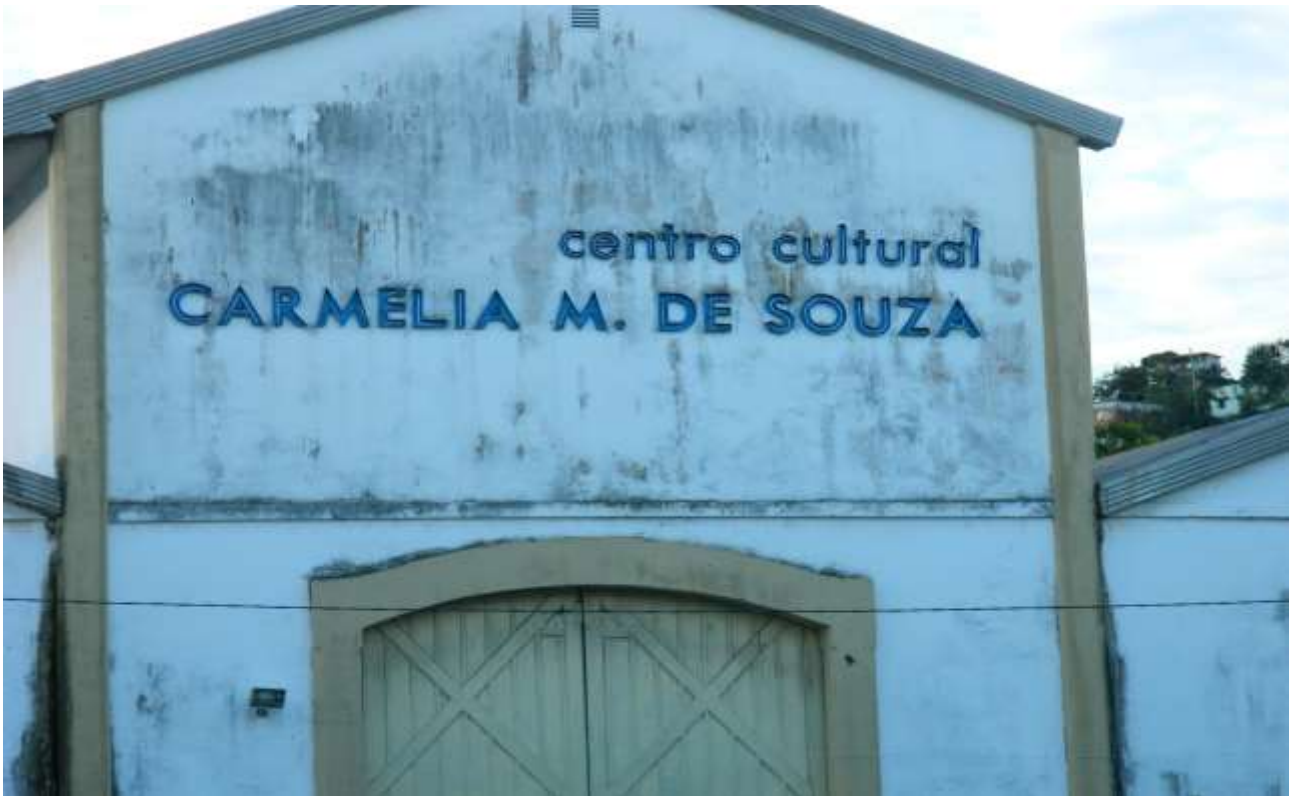
Foto 01- Fachada do teatro onde se localiza à TV da RTV (abandono total)
